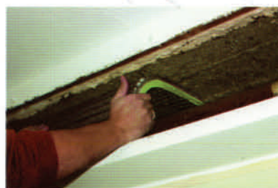
Inserire il pannello schiumato nel vano del cassonetto.
