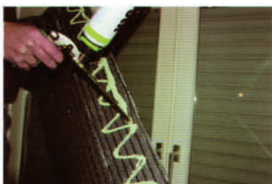
Schiumare il pannello sul bordo superiore o direttamente sul cassonetto.
