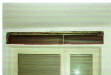
Risultato finale della posa dei pannelli. Per una eventuale revisione tagliare la schiuma sui lati e nella parte inferiore del pannello.
