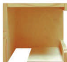
TECNO THERM FLEX inserito dal lato interno del cassonetto.
