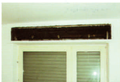
Vano esistente da coibentare.
