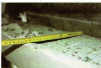
Stabilire la larghezza del pannello sommando le misure delle parti superiore, inferiore e frontale del cassonetto.
