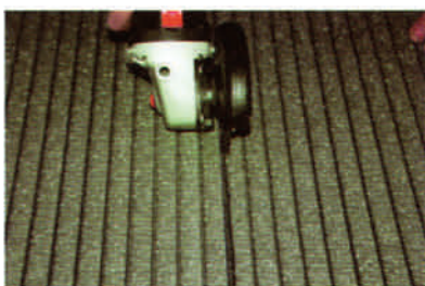
Tagliare il pannello su misura con un flessibile o con una sega alternata.
