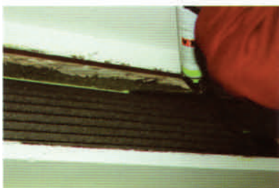
Sigillare il pannello ai lati del vano.
