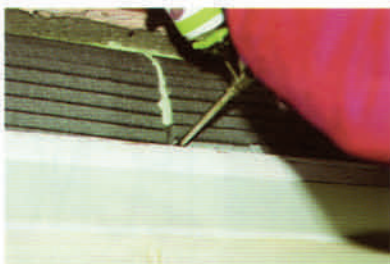
Sigillare con schiuma poliuretamica le giunture fra i pannelli.
