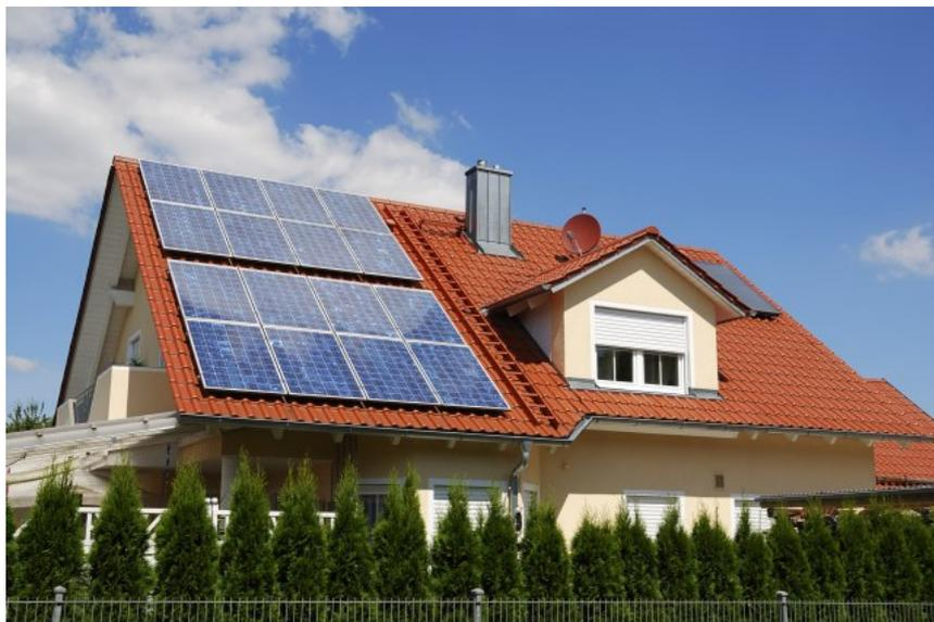
I **pannelli solari termici** sfruttano l'energia del sole **per riscaldare l'acqua** o altro fluido **per il riscaldamento dell'abitazione o dell'acqua sanitaria**, senza l'utilizzo di altri combustibili o elettricità.
